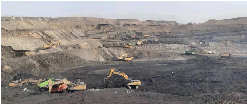
施工团队进行挖土及拨离工作
